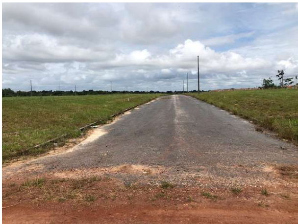
FOTO 43: TRAV. DOS LÍRIOS
