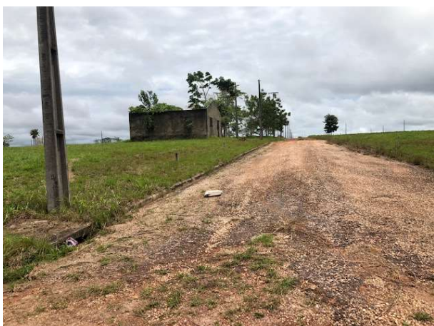
FOTO 51: RUA QUATRO DE JULHO
